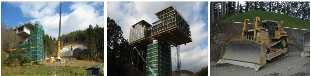
図 1 (3 枚) 橋・トンネル工事現場
