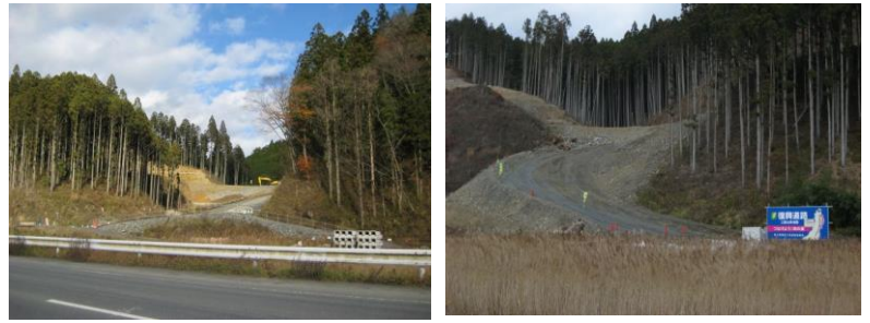
図 2 (2 枚) 商店街近隣の工事現場
